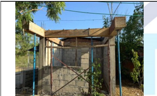
Descripción 2.8: CONCRETO PARA VIGA AÉREA (3000 PSI)
