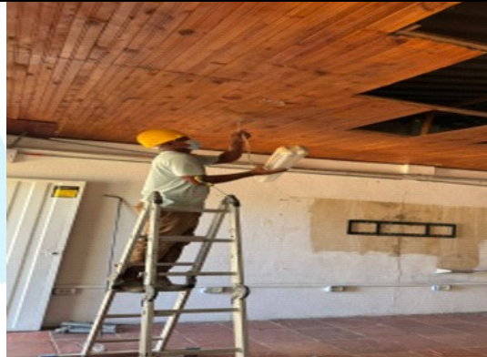
Descripción 1.4: DESMONTAR LUMINARIAS (INCLUYE RETIRO)
