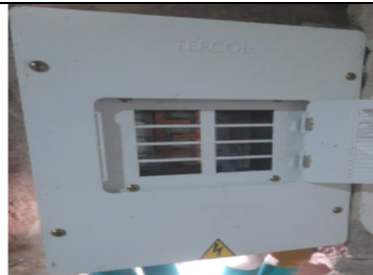
Descripcion 11.2: TABLERO -MONOFASICO (2P + N +T) DE 4 CTOS NQOD SIN ESPACIO PARA TOTALIZADOR BLANCO
