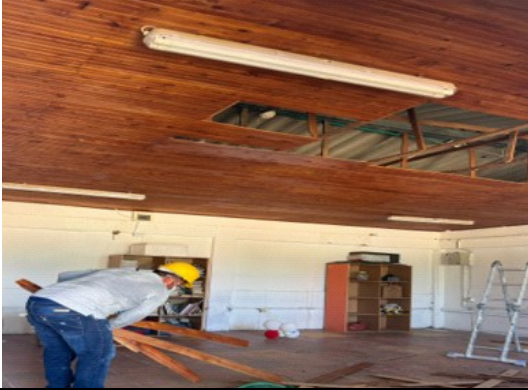
Descripción 1.7: DESMONTE DE CIELO RASO
