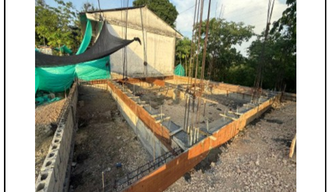
Descripción 2.7: VIGAS DE CIMENTACIÓN CONCRETO (3000 PSI)
