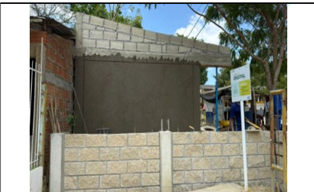
Descripción 4.5: LEVANTAMIENTO DE MURO EN BLOCK #6 ABUZARDADO, CON ACERO Y RELLENO
