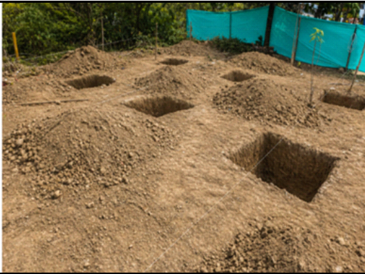
Descripción 2.2: EXCAVACIÓN MANUAL PARA CIMENTACION
