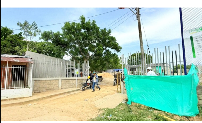
Descripción 8.4: SUMINISTRO E INSTALACIÓN DE TUBOS DE 1 1/2 CADA 20 CM VALOR DEL M DE TUBO
