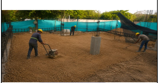
Descripción 2.1: CONFORMACION DEL MATERIAL DEL SITIO
