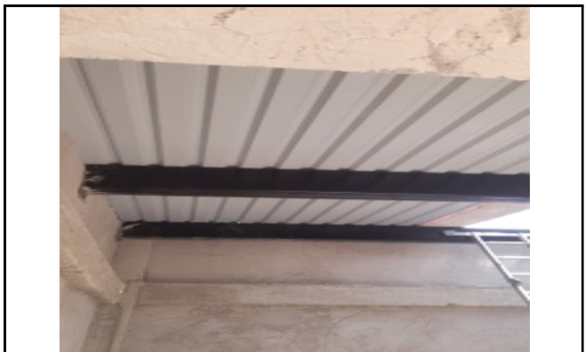
Descripción 5.1: SUMINISTRO E INSTALACIÓN DE CUBIERTA ARQUITECTÓNICA TEJA TRAPEZOIDAL GALVA 106X25 C28, INCLUYE ELEMENTOS DE AMARRE
