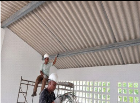
Descripción 1.5: DESMONTAR CABLEADO ELÉCTRICO (INCLUYE RETIRO DE SOBANTES)
