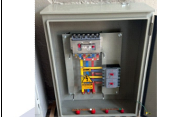
Descripción 9.1: TABLERO PRINCIPAL CGD-1. TABLERO GENERAL DE DISTRIBUCION DE 150 AMP. EN LAMINA GAL PROTECCION IP 44 A 220 VOLT - CGD1 SEGÚN DIAGRAMA UNIFILAR
