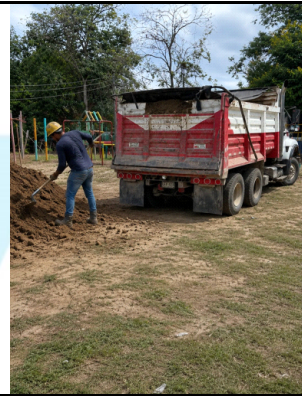
Descripción 2.3: RETIRO DE MATERIAL SOBRANTE DE LAS EXCAVACIONES
