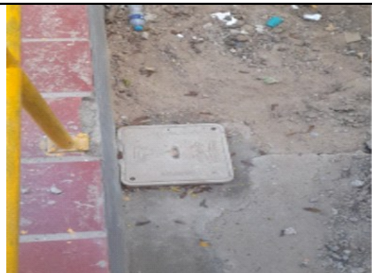
Descripción 14.2: REGISTRO DE BAJA TENSION INSPECCION DE TIERRA 40X40X30
