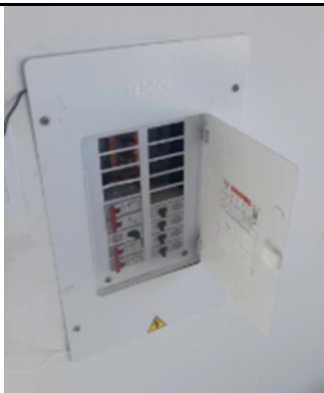
Descripcion 11.1: TABLERO -MONOFASICO (2P + N +T) DE 18 CTOS NQOD CON ESPACIO PARA TOTALIZADOR BLANCO
